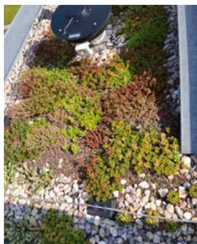
Zelená střecha se skládá ze dvou pultových střech se sklonem 9 a 11°
