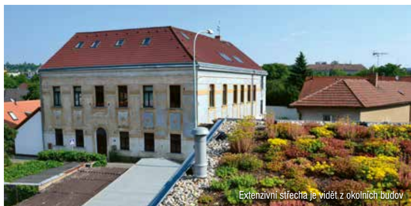
Zelená střecha se skládá ze dvou pultových střech se sklonem 9 a 11°
