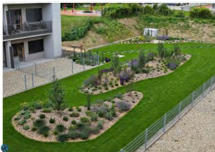
Intenzivní zelené střechy nad garážemi bytového domu - Třebíč
