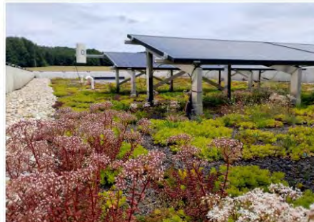
Biosolární zelená střecha na rodinném domě ve Zlíně
