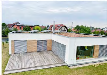
Biosolární zelená střecha na rodinném domě v Čechovicích
