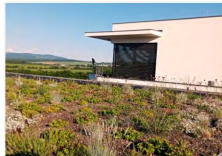
Polointenzivní zelené střechy na rodinném domě v Dobrušce
